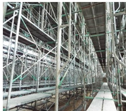
ホール内の足場
